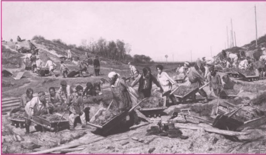
«Ремонтные работы на железной дороге». Художник К. А. Савицкий. 1874
