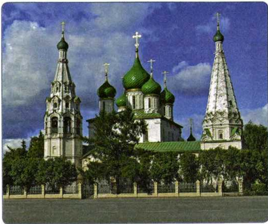
Церковь Ильи Пророка в Ярославле
